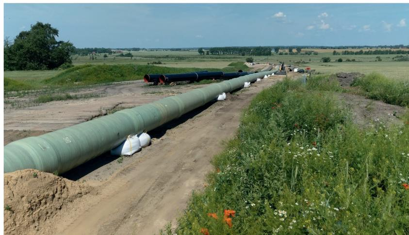
**Bild 2:** 5 mm starke GFK-Rohrummantelung mit 50 mm hohen GFK-Gleitkufen
