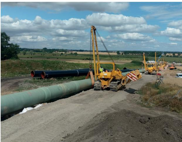
**Bild 1:** Seitenbäume heben den Rohrstrang in Richtung Stahlbetonrohr
